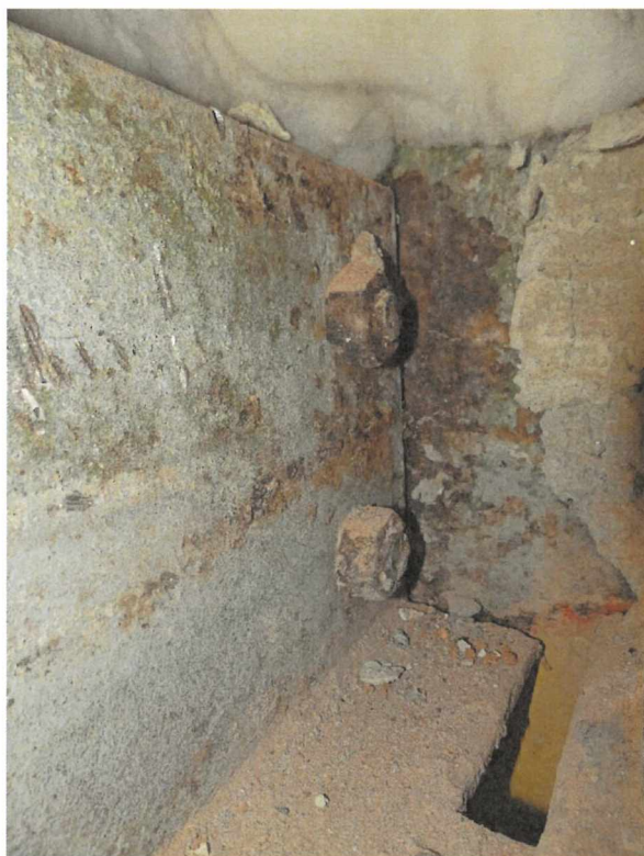
Obr. 3.13: Šroubový přípoj paždíku ke sloupu podélné obvodové stěny (sonda č. 1)
