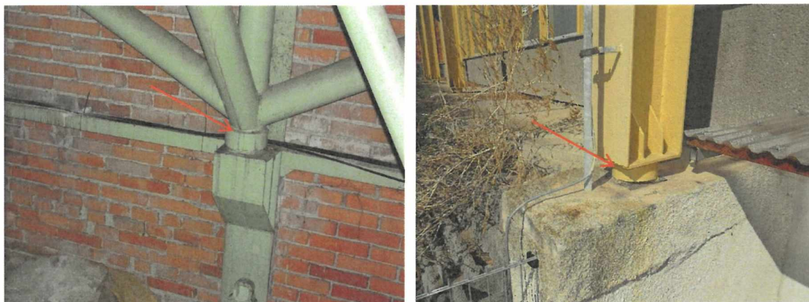
Obr. 3.8: Konstruktivní řešení kloubového spoje (vlevo – uložení stropní desky na sloup; vpravo – uložení sloupu na základ)
