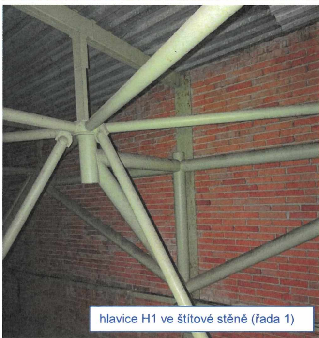
Obr. 3.4: Hlavice příhradové stropní desky – vybrané fotografie
