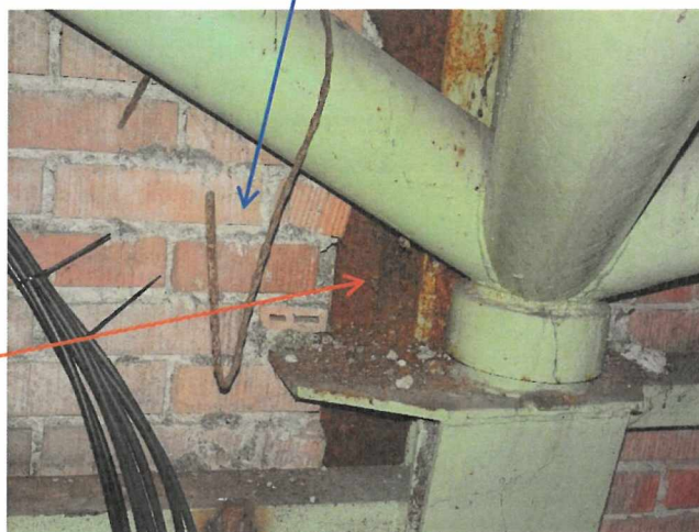
Obr. 4.1: Korozní napadení horní části sloupů (vybrané typické ukázky)
