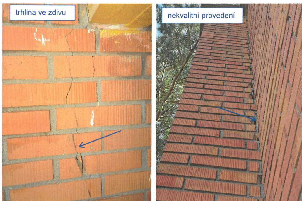
Obr. 5.4: Poruchy obvodového zdiva (vybrané ukázky)
