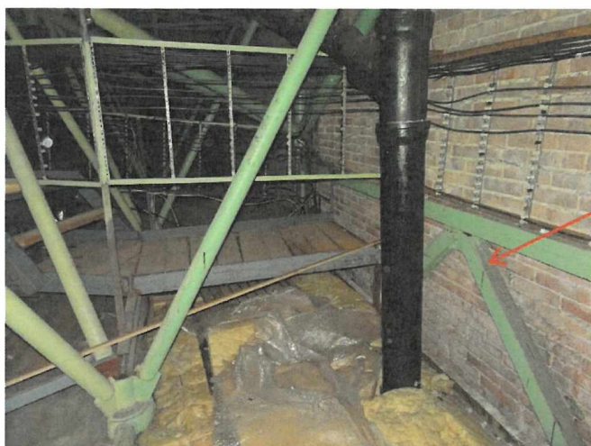
Obr. 3.6: Stěnová ztužidla – vybrané fotografie
