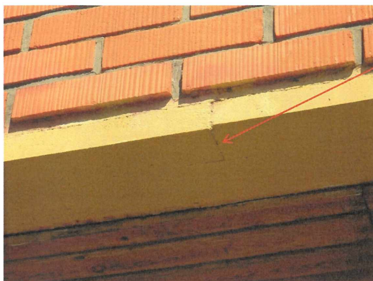
Obr. 5.1: Poruchy paždíků (vybrané ukázky)
