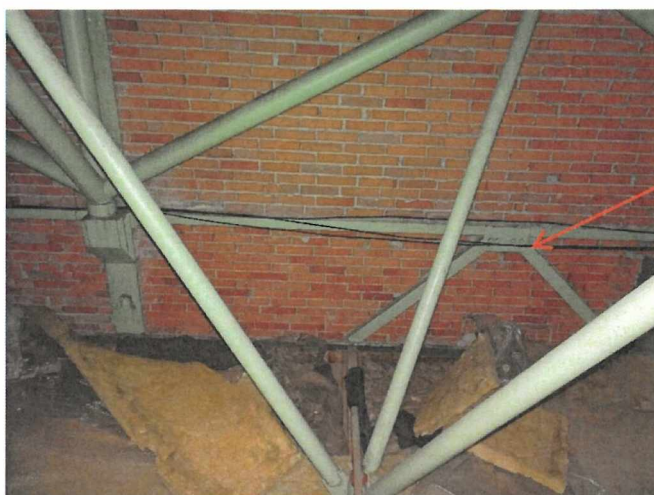
Obr. 3.5: Umístění hlavic a ztužidel [9]
