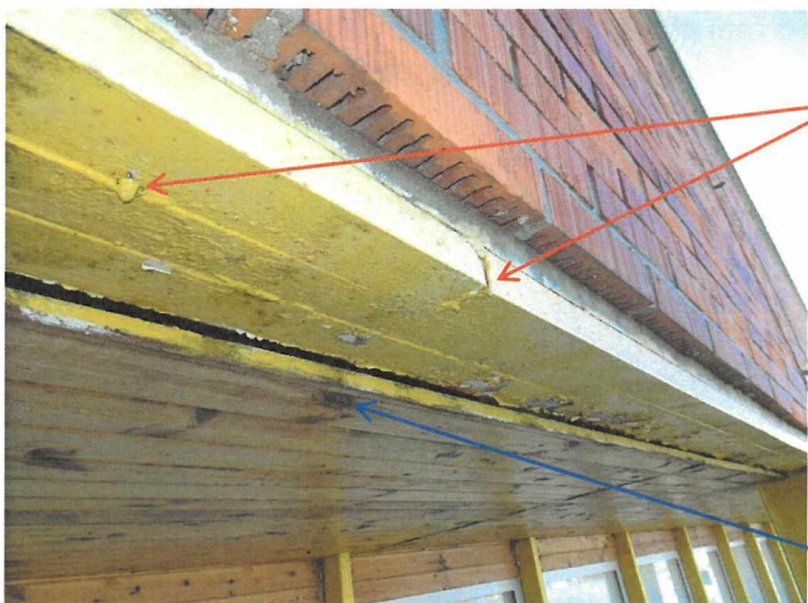
poškozený dřevěný podhled
