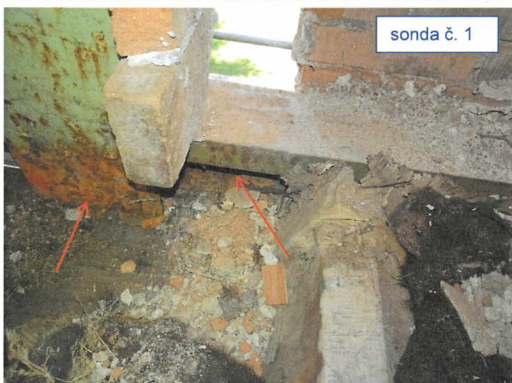
Obr. 4.2: Korozní napadení v oblasti připoje pažníků ke sloupům (vybrané typické ukázky)
