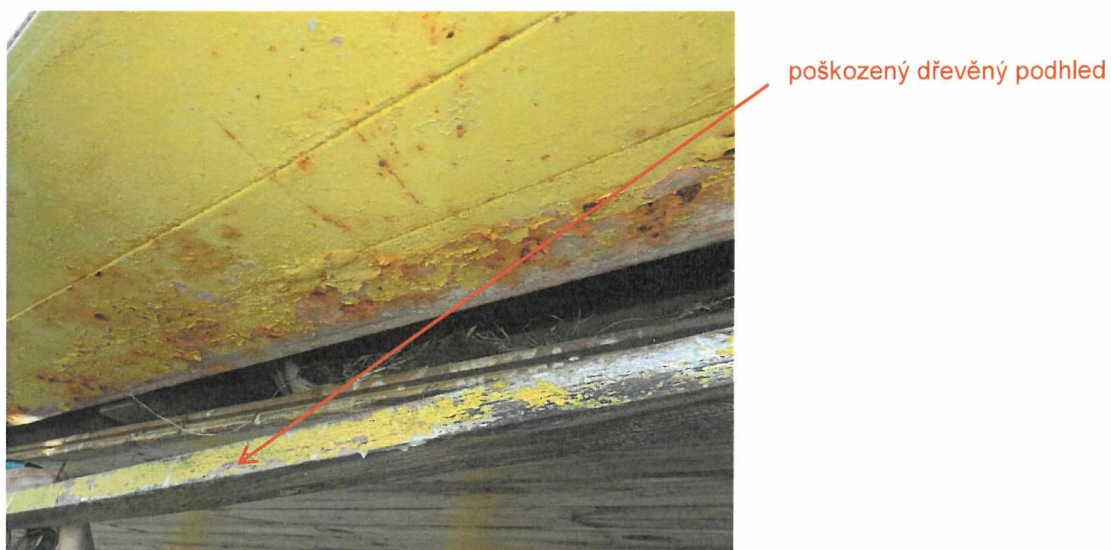
Obr. 5.5: Poškození dřevěného podhledu (vybraná ukázka)
